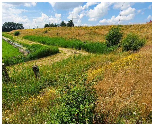
Figuur 51 Nelson Mandelabrug, 8 juli 2021. Onderaan de taluds is gemaaid.
