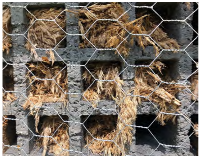
Figuur 60 Niet alle onderdelen uit het bijenhotel waren even functioneel, zo is hier overwegend het verkeerde deel van de rietstengels gebruikt.
