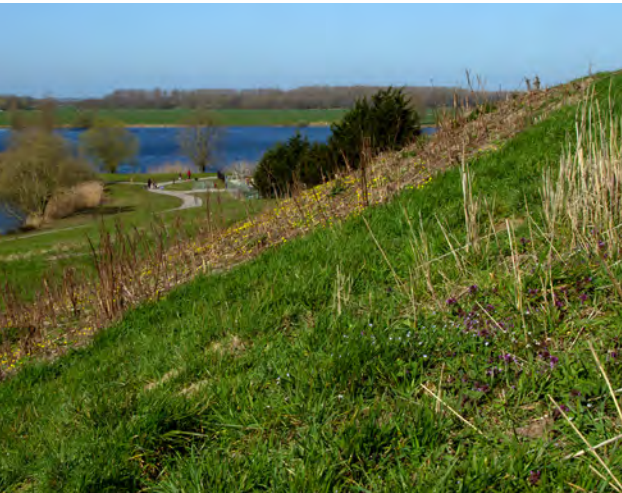
Figuur 70 Zuidrand van het talud waar de skischans op is gebouwd.
