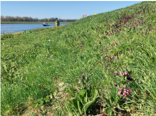
Figuur 3 Botlekbrug 26 april 2021. Op het talud bloeien hondsdrif en smeewortel. Tussen de vegetatie is nog maaisel te zien.
