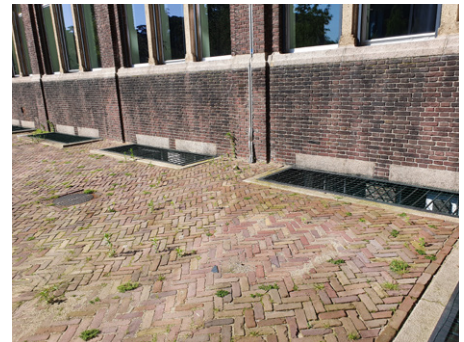
Figuur 17 Locatie 1 Voorplein Bouwkunde ronde 2, op 5 juni 2024. De oostzijde van het plein is het meest zonbeschenen. De ruime voegen tussen gevelstenen en straatstenen bieden nestgelegenheid. De spontaan opgekomen begroeiing tussen de straatstenen biedt blijkbaar voldoende voedsel voor enkele kleine bijensoorten.
