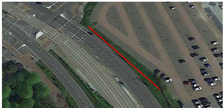
Figuur 52 Locatie 2 Europaweg - berm. Bron Google Earth.
